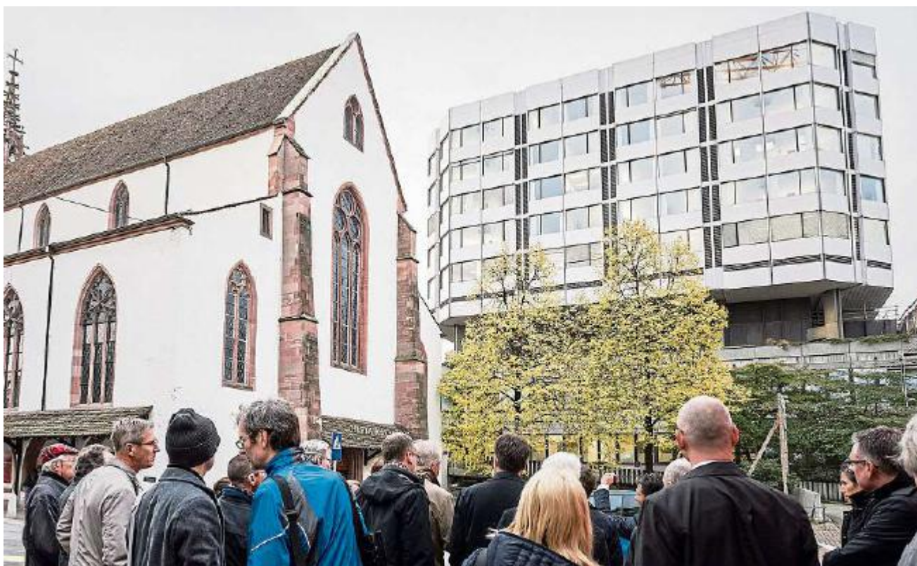
Altstadt verschandelt? Der neue Turm soll höher werden als der heutige Bau, aber harmonischer. Foto Christian Jaeggi
