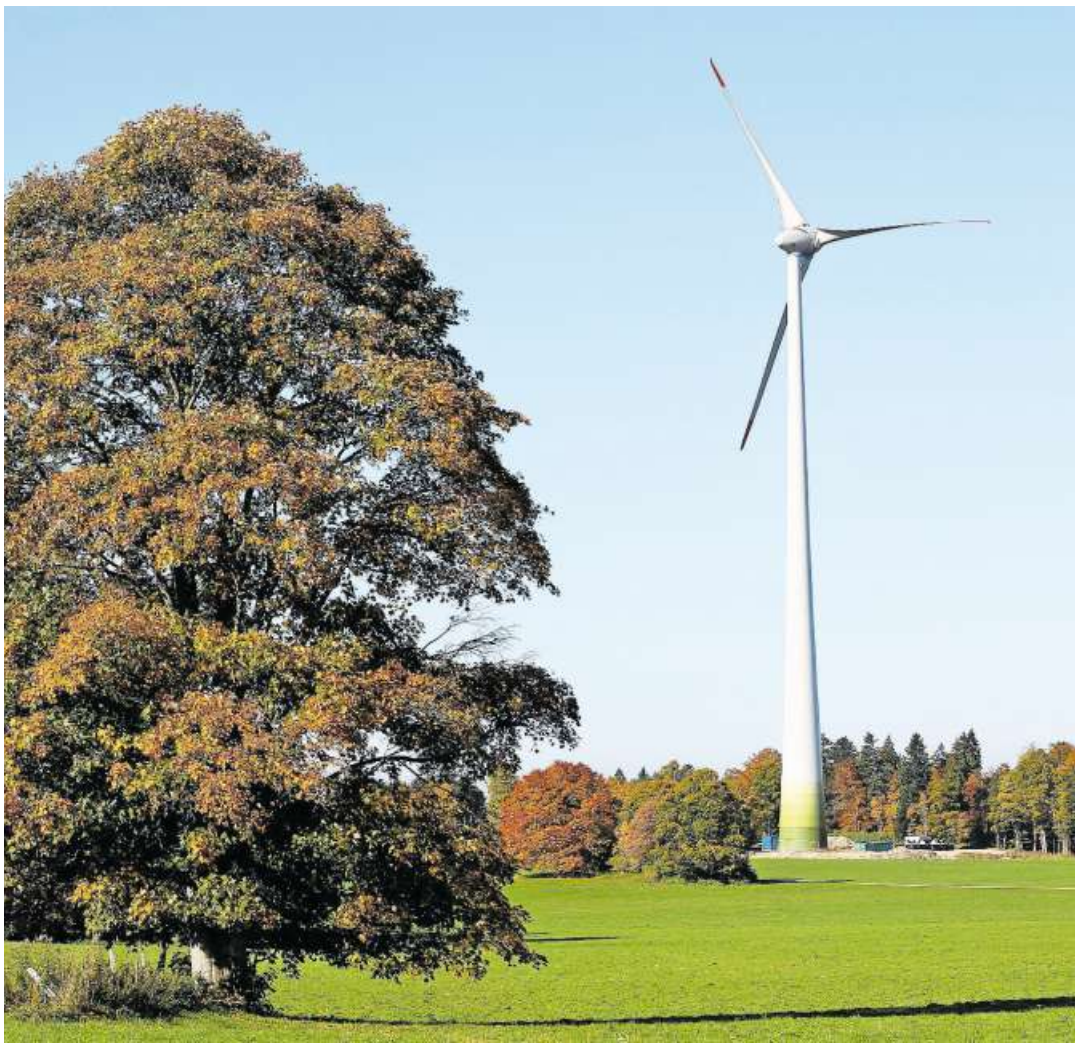
Die Windanlage in Peuchapatte ist eine Todesfalle für die Vögel.
